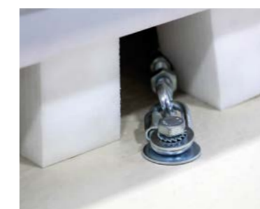
Detail van de anti-rotatiekit
